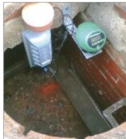
CSO 闸室内 IMP 监测
