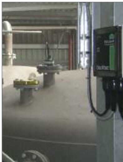
水罐上的法兰传感器
