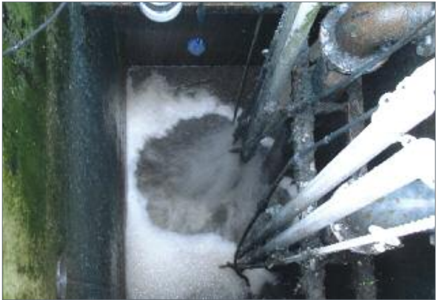
4m 湿井 (集水井) 泵控制和高填充率
