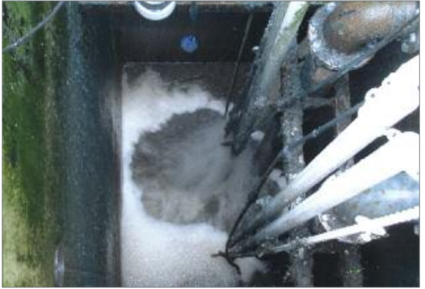
4m 湿井 (集水井) 泵控制和高填充率
