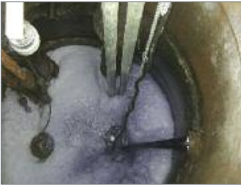
3.5m 泡沫湿井 (集水井) 泵控制
