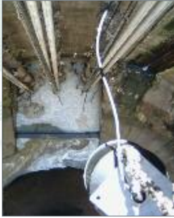
27m雨水罐 3 台泵在中心井下面
