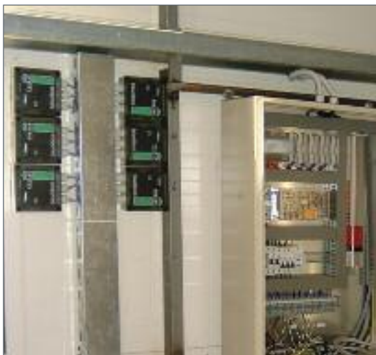
石油罐料位仪
