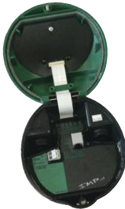
石灰液罐上的 IMP
