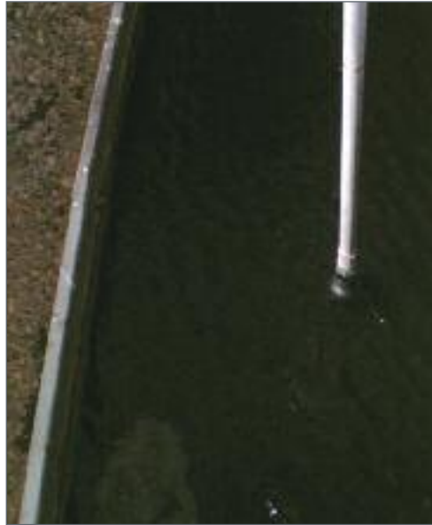
擦拭器的清扫动作防止了“毛状物”的堵塞，确保了轴不会随着时间流逝而被禁锢。
