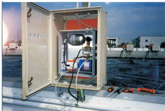
自带自清洗压缩空气的典型安装
